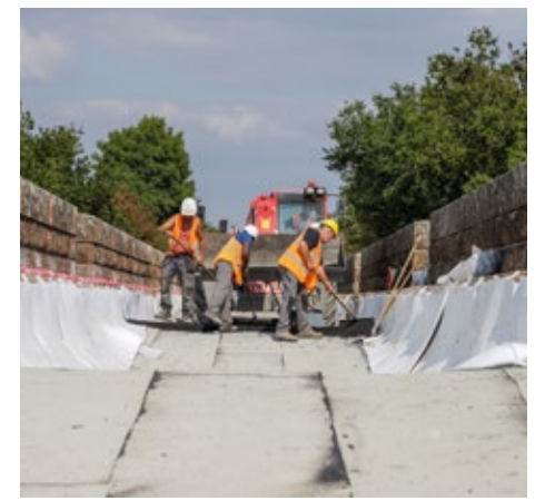
Travaux sur ouvrage d'art
